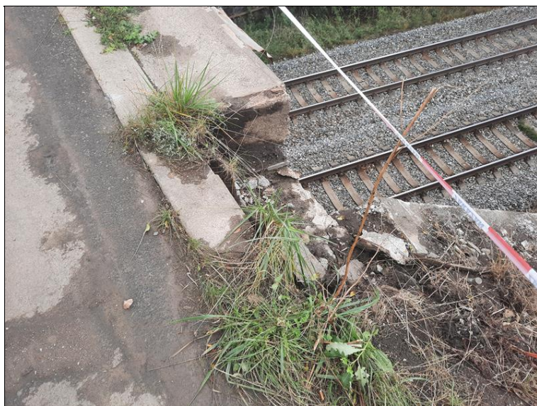
Pravá římsa - začátek mostu - detail
