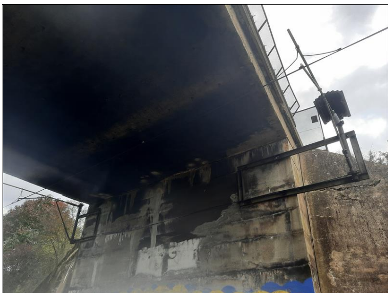
Stopy provádění diagnostiky - uložení na opěře 2, pohled NK
